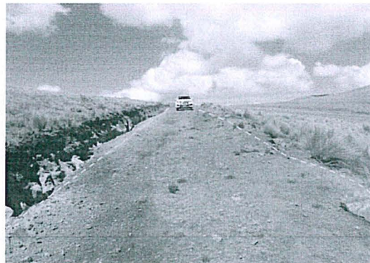
Fuente: Informe de Supervisión
