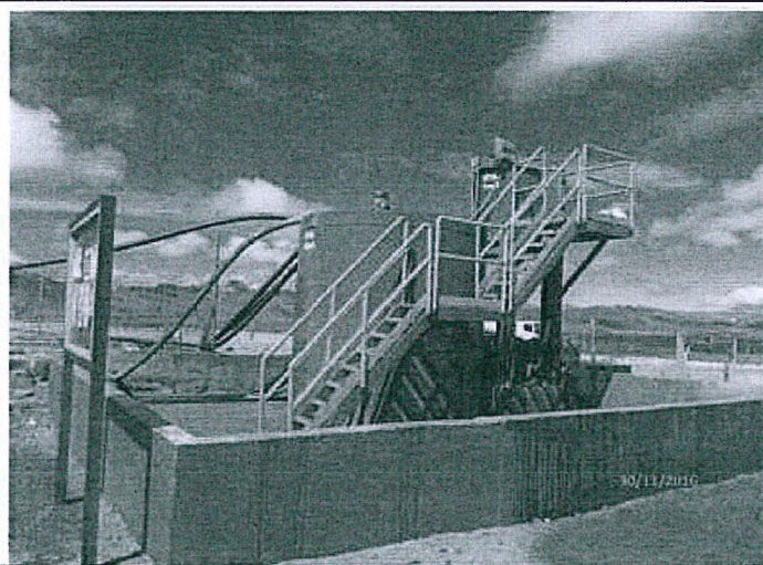
Foto N° 06: En las coordenadas N: 8782606 E: 0339540, se culminó con la construcción del sistema de contingencia, esta tiene una capacidad de 23 m3.
