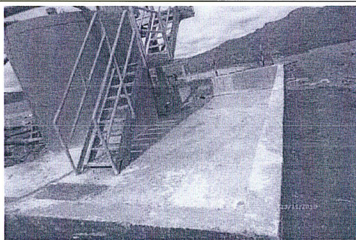
Foto N° 04: En las coordenadas N: 8782606 E: 0339540 se realizó la construcción de la loza (piso) del sistema de contingencia.
