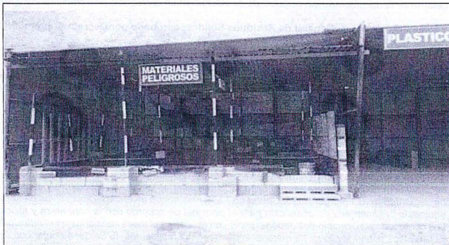
perimétrico total ni presentaba puerta de ingreso, esto se corrobora de la revisión de la fotografía N° 9 adjunta al citado Informe de Supervisión, fotografía en la cual se aprecia que dicho almacén se encuentra techado y cercado con malla tipo raschel y provista de barreras de contención y parihuelas de madera; sin embargo, no se encuentra cerrado, incumpliendo de esta manera lo establecido en el primer párrafo del artículo 40° del RLGRS.
