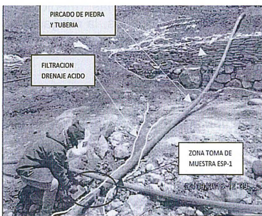
Fotografía N° 103: Vista fotográfica donde se observa el punto de control ESP-1. Filtración de agua que descarga al cuerpo receptor Quebrada Hércules, con coordenadas (Datum WGS-84) E 219 085, N 8 919 207.
