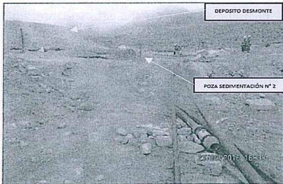
Fotografía N° 76: Hallazgo N°2, vista fotográfica de la descarga de la poza de sedimentación A mediante una tubería HDPE 4\"
