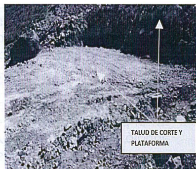
Subsanación (Hecho Imputado N° 9): En el lugar, no se observa filtración de agua que descargue al cuerpo receptor Quebrada Hércules
