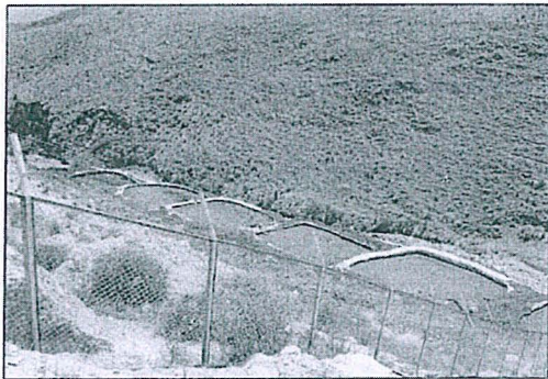
Fotografía N° 69: Hallazgo N°1. Vista de las pozas de sedimentación las cuales se encuentran sin revestimiento, asimismo, cuentan con un área aproximada de 10m 2 cada uno (margen derecha del río Hércules).
