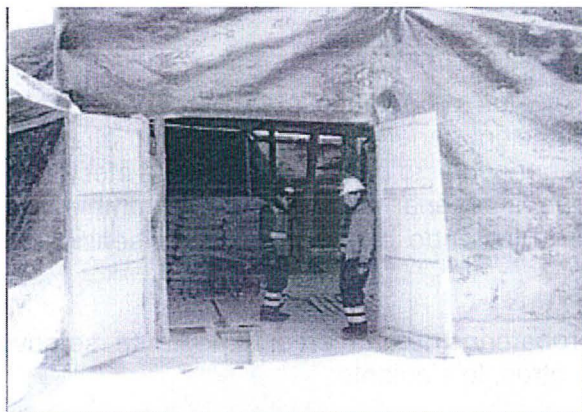
Fotografía N° 84: Hallazgo N°4, Vista frontal del almacén de cal ubicada en la Planta de tratamiento de aguas de mina.
