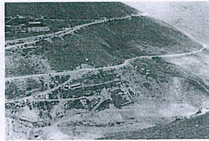
Subsanación (Hecho Imputado N° 1): Durante la supervisión del OEFA, las pozas contaban con impermeabilización de arcilla. Actualmente, no se evidencia las pozas en mención
