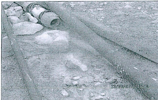
Fotografía N° 77: Hallazgo N°2, vista fotográfica de la descarga de la poza de sedimentación A mediante una tubería HDPE 4\"
