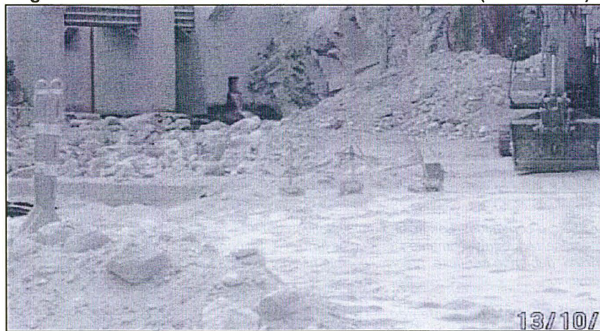
Imagen N° 2: Avance en el retiro de material excedente (Zona Presa)
