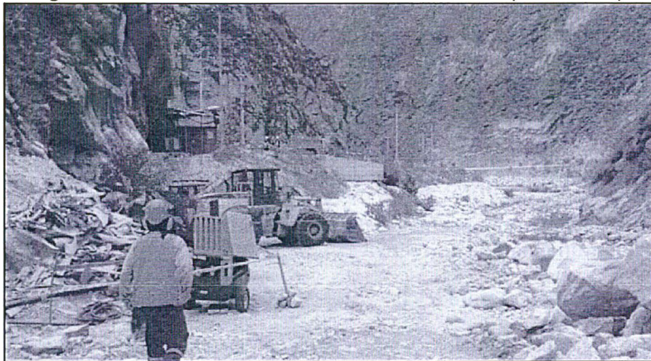
Imagen N° 1: Avance en el retiro de material excedente (Zona Presa)
