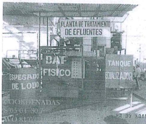
Foto N° 01 : DAF FISICO, TANQUE ECUALIZADOR y ESPEADOR DE LODOS
