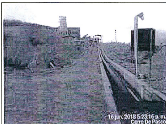
Fotografías 09 y 10.- Otras vistas de la tubería HDPE de 18" conectada desde el cajón de relaves hasta la poza de eventos. Nótese que la tubería HDPE se encuentra dentro del canal de contingencia de concreto
