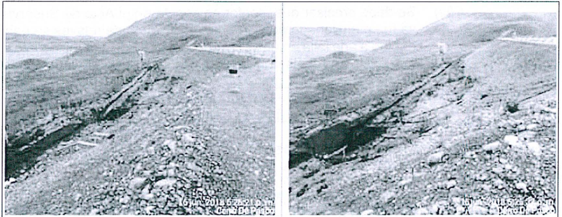
Fotografías 11 y 12.- Vistas del canal abierto de geomembrana que fue construido en la parte baja de la Poza de Eventos. Se puede observar cajón de recepción desde se bombearía hacia la poza de eventos. Coordenadas WGS 84 N: 8 818 150 E: 360 087
