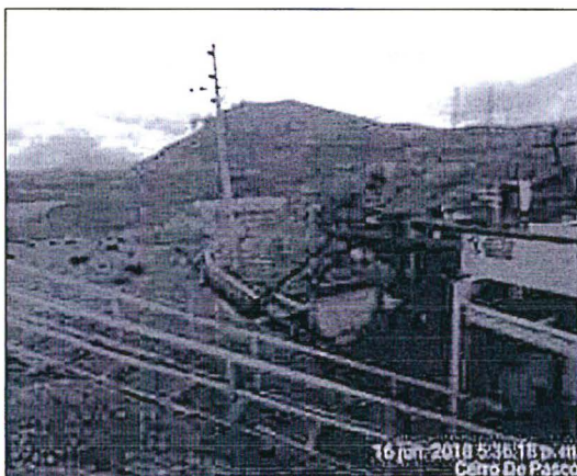
Fotografías 07 y 08.- Vista de la tubería HDPE de 18" conectada desde el cajón de relaves hasta la poza de eventos. Nótese que la tubería HDPE se encuentra dentro del canal de contingencia de concreto Coordenadas WGS 84 N: 8 818 222 E: 360 083
