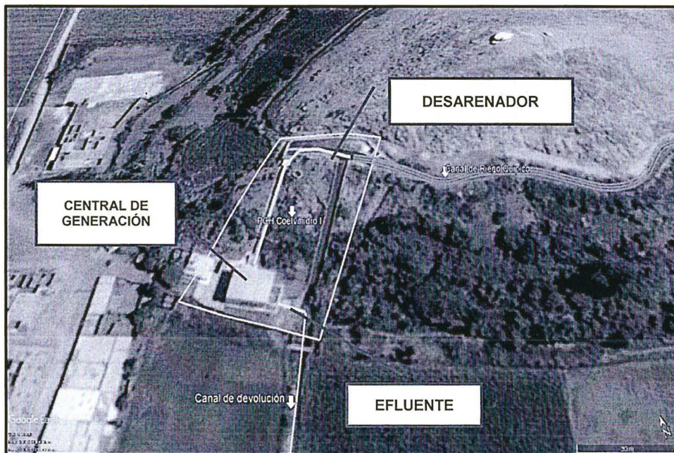
Imagen N° 2: Vista de la Central Hidroeléctrica Coelvihidro I
