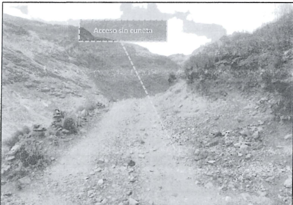
Fotografía N° 10. Vista de la vía de acceso colindante a la plataforma 33, en donde además se observó que el área de rodaje presentaba cascajos, asimismo a su margen izquierdo y derecho se verificó presencia de ichu y roquedales.
