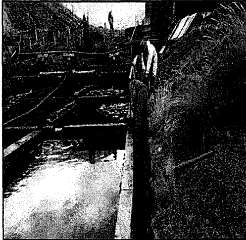
Fotografía N° 1: Vista antes de la construcción del muro canal de contingencia en la cocha de polimetálicos.
