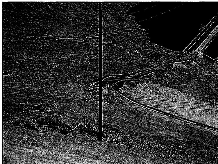
Fotografía N° 07 tomada en la actualidad. Se observan 03 tuberías desmontadas y tendido de nueva tubería de bombeo de ILS.
