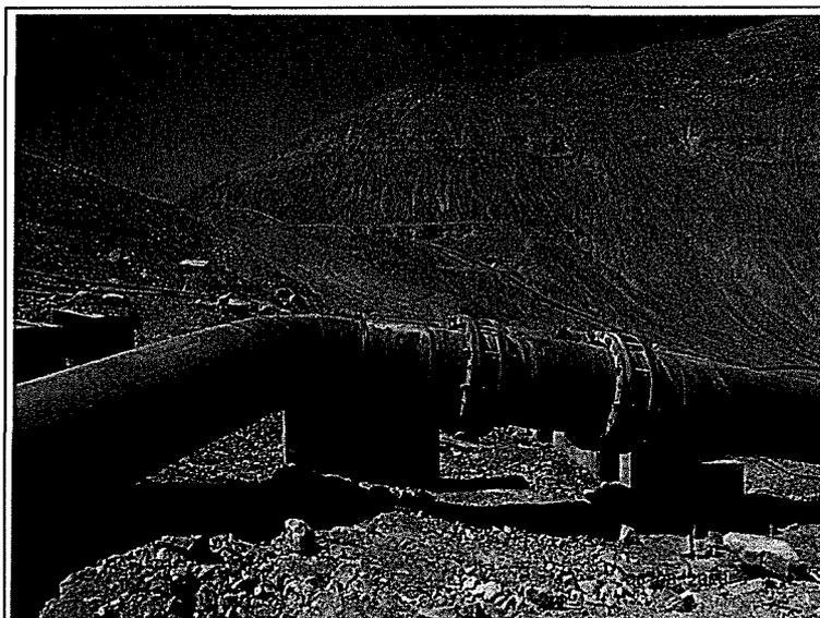
Fotografía N° 04. Empalme de tubería de 22" a línea de 20" que conduce ILS al Booster 2.
