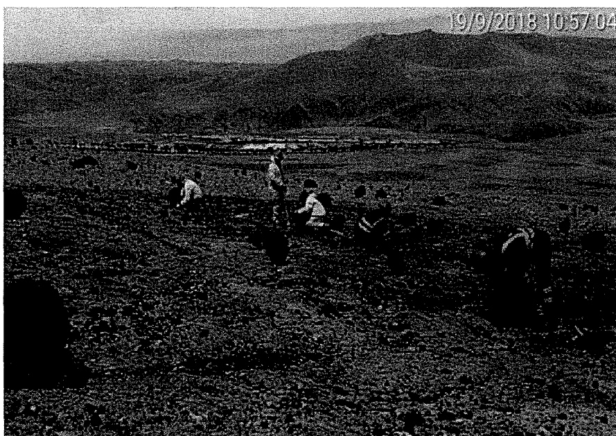
Fotografía No.17: Se evidencia el retiro de material excedente en la curva Cumani, así como la remediación y revegetación del área en coordenadas N° 8423249 y E 957037
