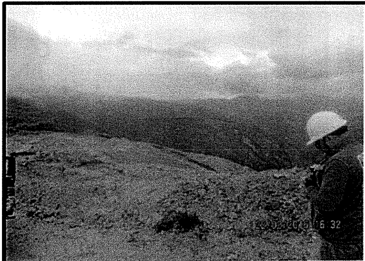
FOTOGRAFÍA N° 04.- Depósito de desmonte Coluvial Norte: no se observa disposición de material reciente, la carga se observa asentada, con visible signos de erosión.
