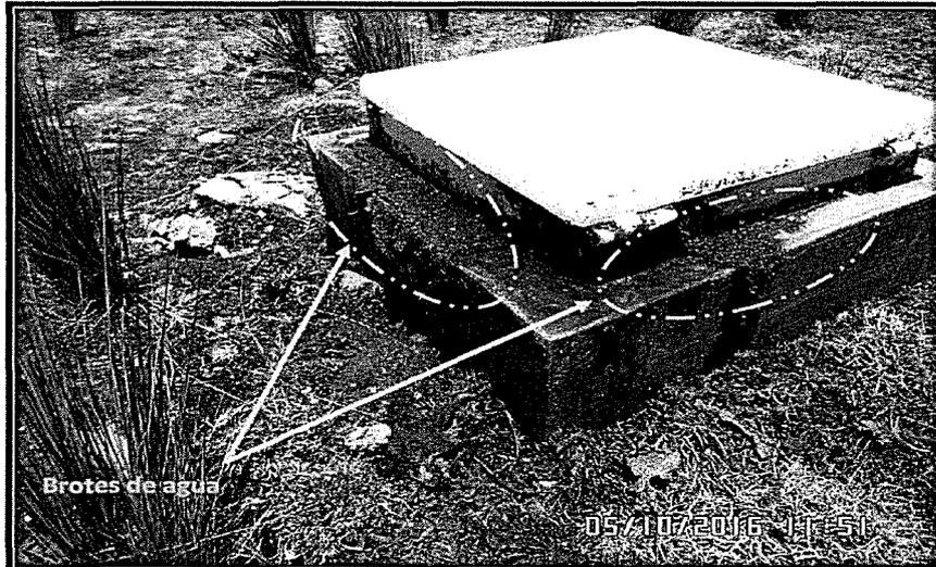
Fotografía N° 29: Hallazgo N° 4: Acercamiento al dado de concreto encontrado en el área de la plataforma 82. Se observó que contaba con tapa metálica y que de su interior brotaba agua.
