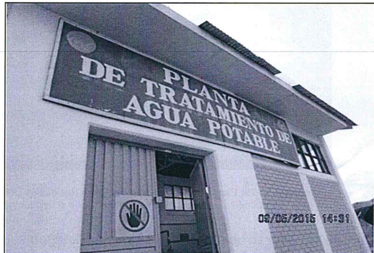
Fotografía N° 82: Planta de Tratamiento de Agua Potable – PTAP. Componente activo; procesa agua proveniente de la zona de Tumiri, surtiendo del recurso necesario a campamentos, comedor y oficinas administrativas. Consta de tanques de agua no potable, bombas, filtros de diversas características, dosificadores de hipoclorito de calcio, tanque de agua tratada y líneas finales de distribución. Aún no se han ejecutado actividades de cierre.
