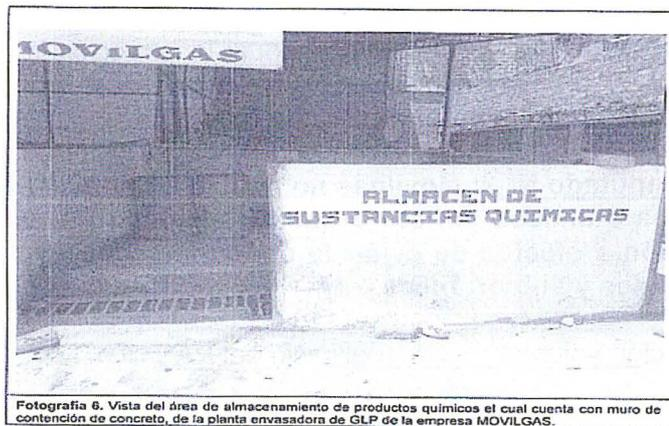
Fotografía 6. Vista del área de almacenamiento de productos químicos el cual cuenta con muro de contención de concreto, de la planta envasadora de GLP de la empresa MOVILGAS.
