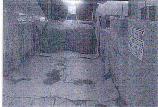
Fotografía N° 2. – Área donde se almacenamiento actual del sulfato, con sistema de contención
