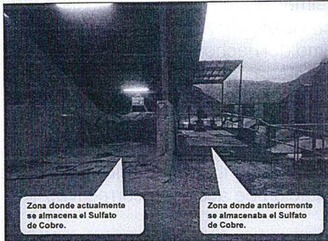
Fotografía N° 1. – Área donde se almacenamiento actual del sulfato, con sistema de contención ante derrames.
