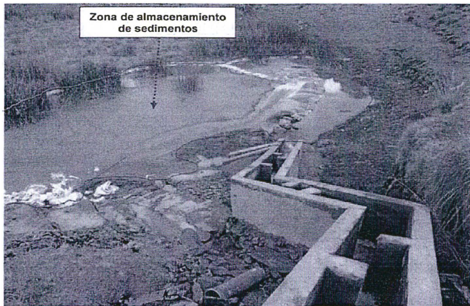
FOTO N° 81. Hallazgo 3 – Supervisión 2015. Canal aguas abajo del punto de muestreo de efluentes S-2, con su descarga a la laguna Mancancoto.
