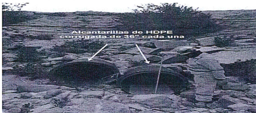
Fotografía 1: Punto de ingreso – alcantarillas de 36 pulgadas. Sistema de drenaje de plataforma – ventana intermedia
