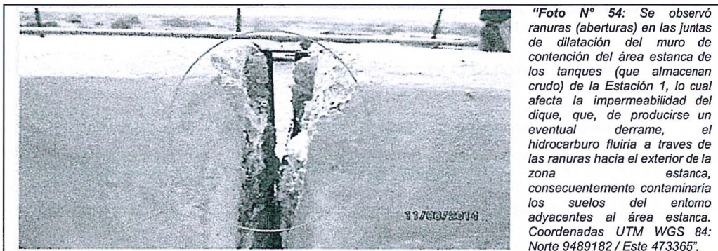
Cuadro N° 8: Fotografía N° 54 del Informe de Supervisión - Junta de dilatación de área estanca de los tanques de crudo en la Estación 1 - Lote VII
