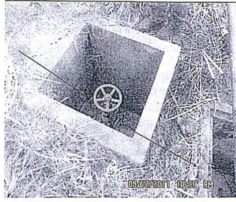
Fotografía N° 5-B: Se aprecia la válvula que controla línea de descarga del drenaje pluvial que permite el paso de los fluidos hacia la trampa de grasas.
