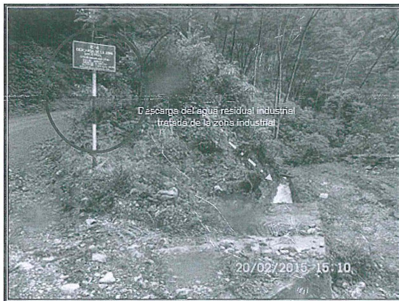
Fotografía N° 118: Punto de muestreo 332, 1, E-6. En la descarga del agua residual industrial tratada proveniente de la zona industrial, en las coordenadas UTM WGS 84, 458383E y 8758389N.
