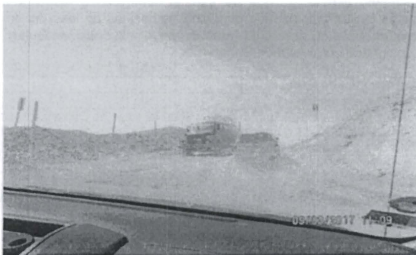
Fotografía N° 6: Vista fotográfica del acceso con dirección al tajo. Un camión cisterna se encontraba realizando el riego en la vía
