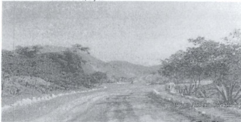
Fotografía N° 4: Vista fotográfica del acceso con dirección al depósito de desmonte. Se observa el suelo con presencia de agua, proveniente del riego efectuado por una cisterna.
