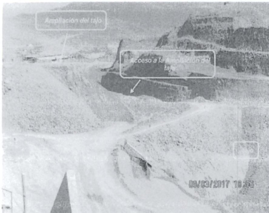
Fotografía N° 12: Vista fotográfica del tajo y un acceso hacia una ampliación del tajo.
