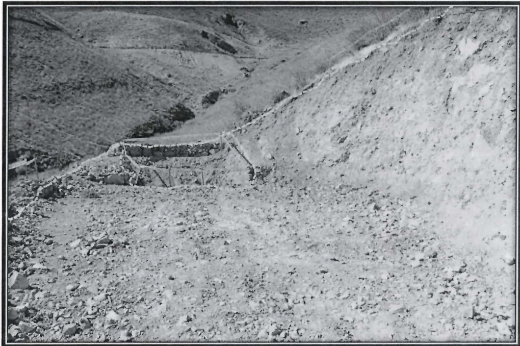
Fotografía N° 33: HALLAZGO (GABINETE) Vista panorámica del Plataforma S/N, se observó el corte de talud expuesto. Además, se verifico en el área una zanja señalizada con cinta de seguridad de color amarilla. Coordenadas (Datum WGS 84 – Zona 18) E: 284083 N: 8759182.
