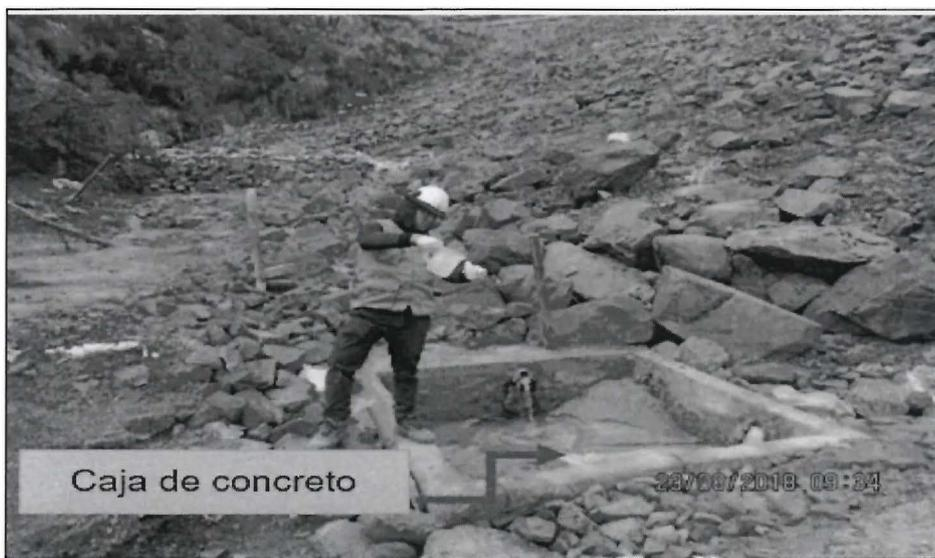
**Fotografía N° 59:** Vista de la caja de concreto de captación del sub drenaje de la cancha de relaves Santa Catalina, que luego es descargada a la quebrada Santa Catalina.
