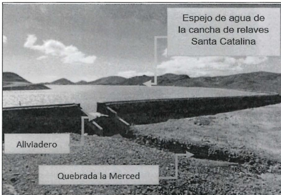
**Fotografía N° 3:** Vista del Canal que colectaría agua del aliviadero construido de concreto, con descarga a la quebrada La Merced, afluente del río Shorey.
