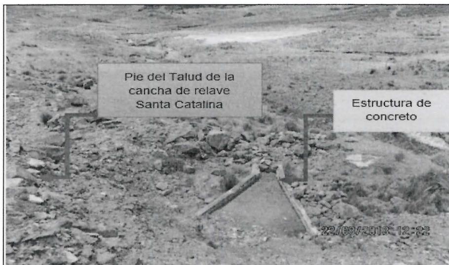
**Fotografía N° 56:** Vista del pie de talud de la cancha de relaves Santa Catalina, donde se encuentra una estructura de captación del flujo de agua ácida proveniente de dicho dique, y que luego conducido por una tubería de HDPE enterrada.
