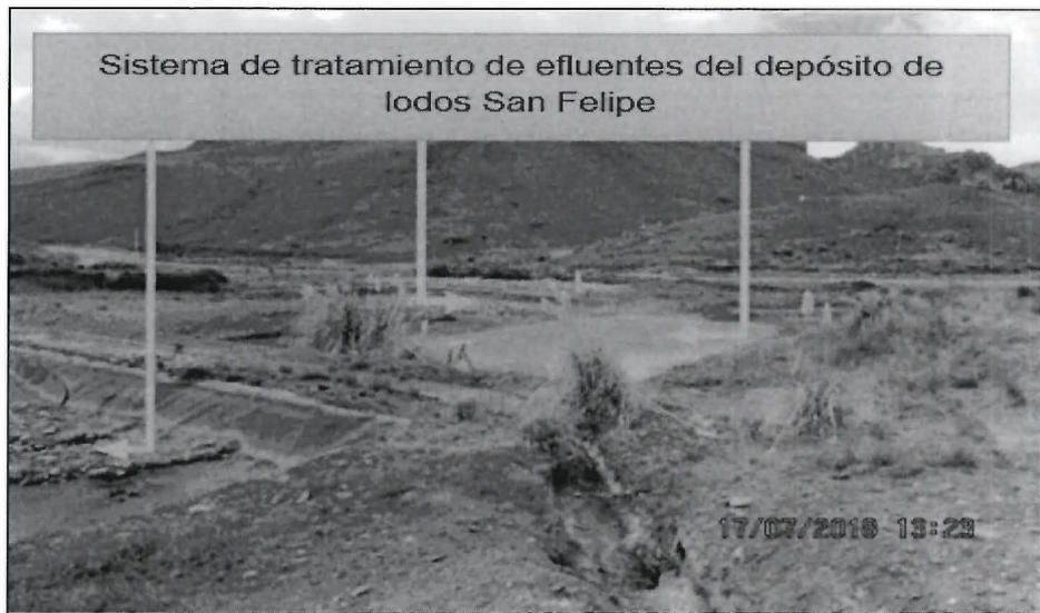
**Fotografía N° 13:** Vista del sistema de tratamiento de efluentes del depósito de lodos San Felipe conformado por pozas, con descarga final al río Shorey; el sistema se encuentra inoperativo, sirviendo actualmente como medio de tránsito de los efluentes hacia el mencionado río.
