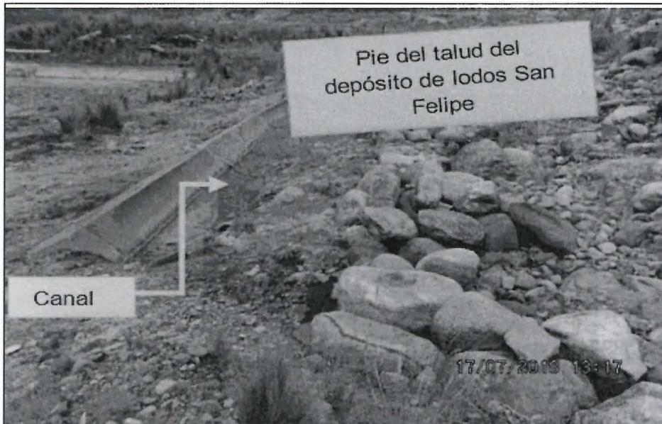
**Fotografía N° 12:** Vista del canal de concreto ubicado al pie del talud externo del dique del depósito de lodos San Felipe, empleado para la colección de filtraciones de agua con descarga al río Shorey.
