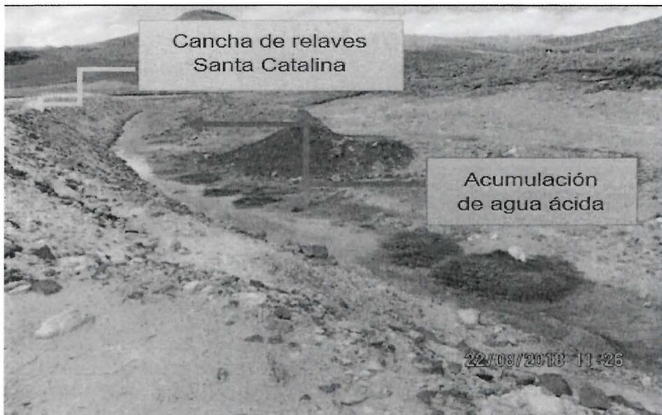
**Fotografía N° 52:** Vista del talud externo de la berma de la cancha de relaves Santa Catalina.
