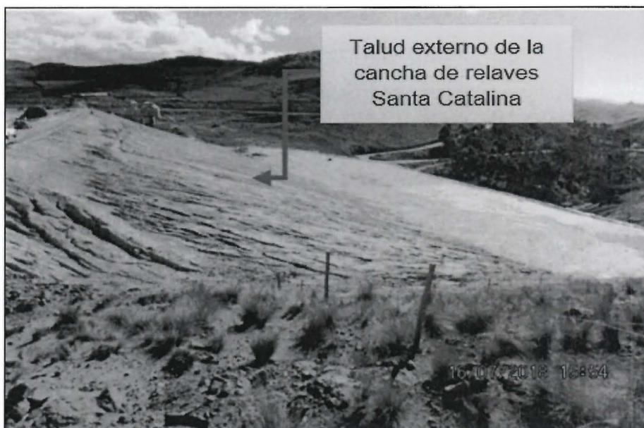
**Fotografía N° 7:** Vista de agrietamientos y cárcavas en el talud externo de la cancha de relaves Santa Catalina, originados por la erosión hídrica del agua de lluvia.
