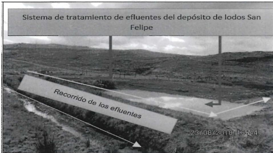
**Fotografía N° 68:** Vista del sistema de tratamiento de efluentes del depósito de lodos San Felipe conformado por cinco pozas, con descarga final al río Shorey; el sistema se encuentra inoperativo, sirviendo actualmente como medio de tránsito de los efluentes hacia el mencionado río Shorey.
