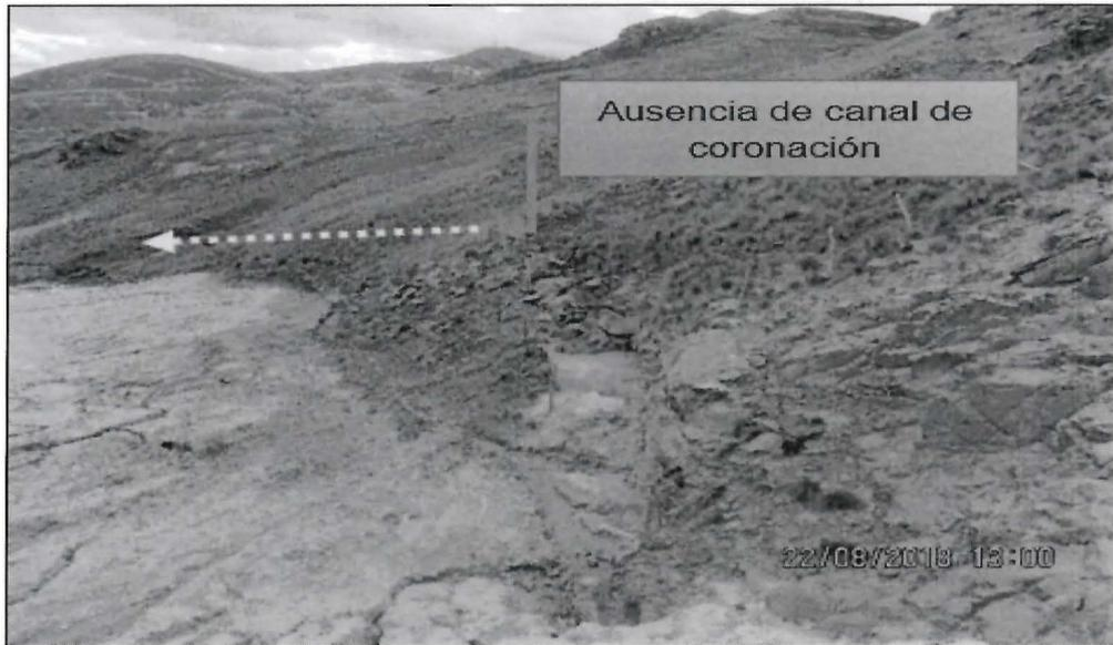
**Fotografía N° 50:** Vista del área ubicado al lado Noroeste de la cancha de relave Santa Catalina, donde falta la construcción del canal de coronación.
