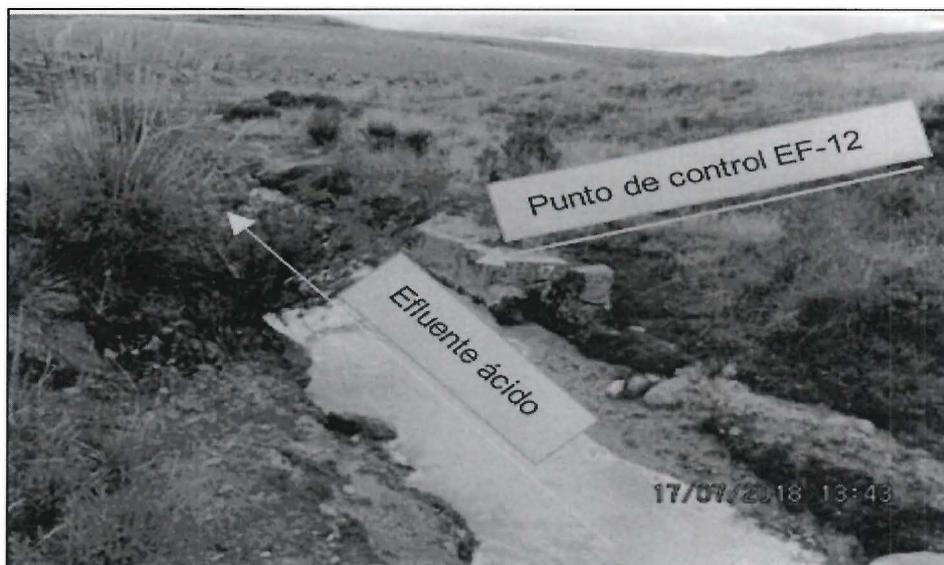
**Fotografía N° 14:** Vista del punto de control EF-12 a través del cual se vierten todos los efluentes generados en el depósito de lodos San Felipe, hacia el río Shorey.
