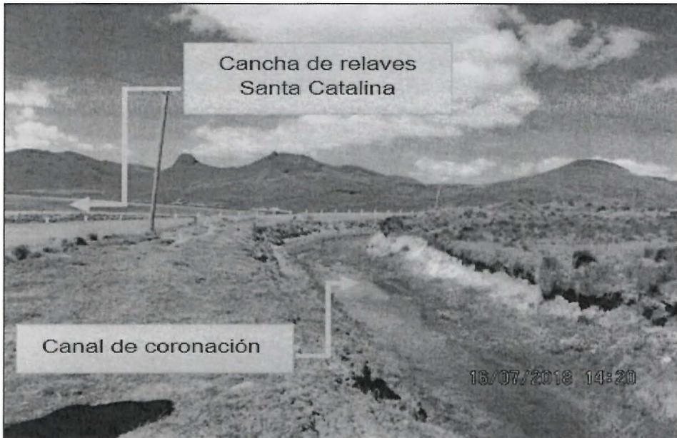
**Fotografía N° 1:** Vista del canal de coronación de la parte superior de la cancha de relaves Santa Catalina; se observó operativo y con presencia de vegetación.
