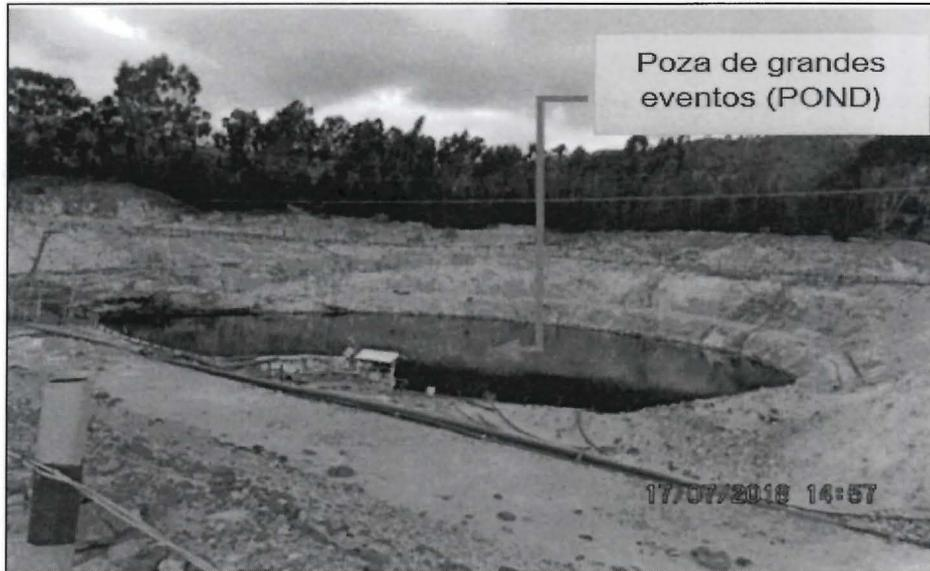
**Fotografía N° 17:** Vista de la poza de grandes eventos (POND), donde llega el agua ácida proveniente de la bocamina Almirvilca.
