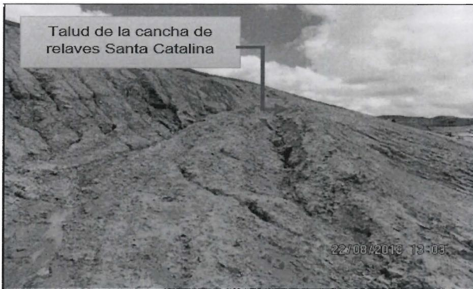
**Fotografía N° 58:** Vista de agrietamientos y cárcavas en el talud externo del dique principal de la cancha de relaves Santa Catalina, originados por la erosión hídrica del agua de lluvia.
