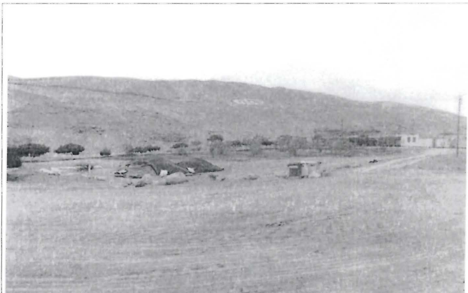
Fotografía N° 098: Hallazgo N° 4, El mineral almacenado en la parte exterior está constituido por dos pilas de mineral, también nótese el cambio de color del suelo de la plataforma de almacenamiento y el color del suelo natural.
