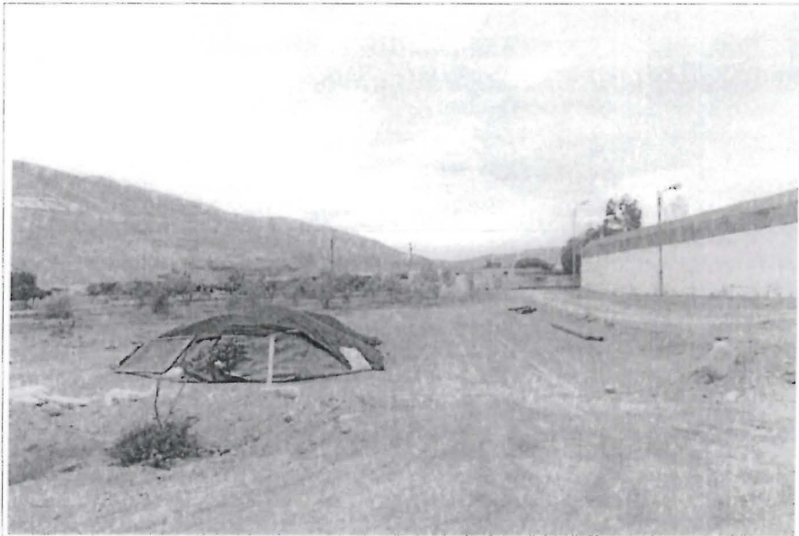
Fotografía N° 097: Hallazgo N° 4, Nótese, las huellas sobre el suelo que dejan las llantas debido al paso de equipos. También debido a los derrames de mineral el color del suelo o plataforma es plumiza.
