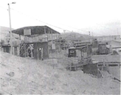
Fotografía N° 035: HALLAZGO N° 01, Vista general del tanque de preparación y almacenamiento de solución de cianuro.
