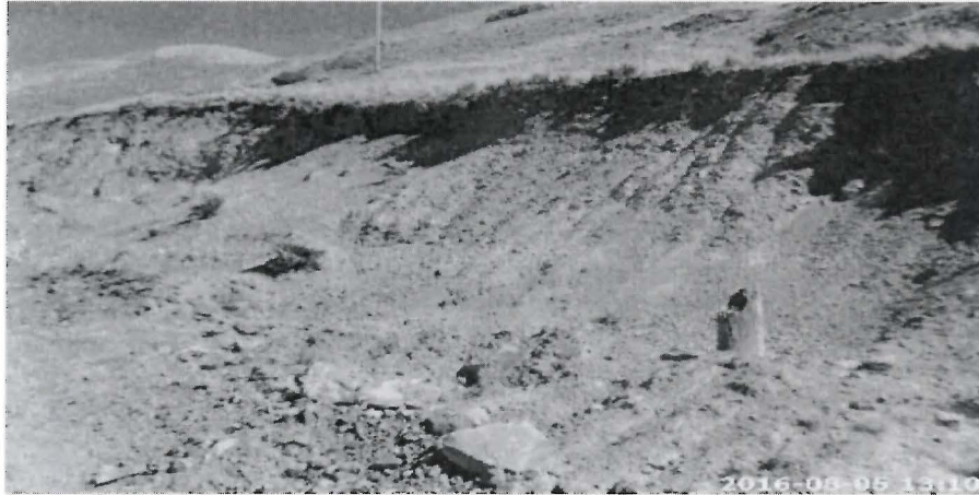
Fotografía N° 113: Hallazgo de gabinete N° 2: Se observó que en el depósito de desmonte N° 3, el desmonte ha sido retirado, quedando expuesta inferior del suelo.
