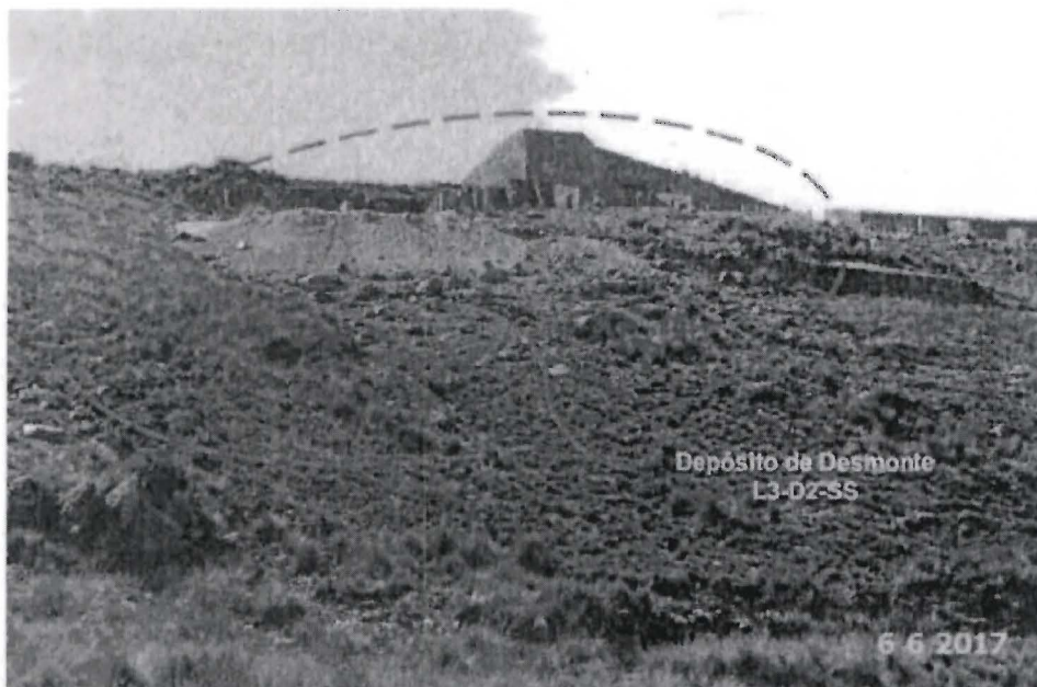
Fotografía N° 83: Vista panorámica del Depósito de desmonte L3-D2-SS, ubicado en coordenadas UTM (WGS 84), E: 228219 N: 8912711, se observa material expuesto al ambiente y vegetación en el pie de su talud.
