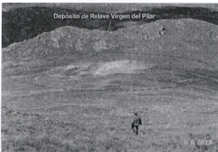
Fotografía N° 91: Vista panorámica del Depósito de relave Virgen del Pilar, ubicado en coordenadas UTM (WGS 84), E: 229338 N: 8913222, en medio de una lomada, se observa el material expuesto al ambiente, y en un sector se observó de coloración naranja oscuro producto de la oxidación.
