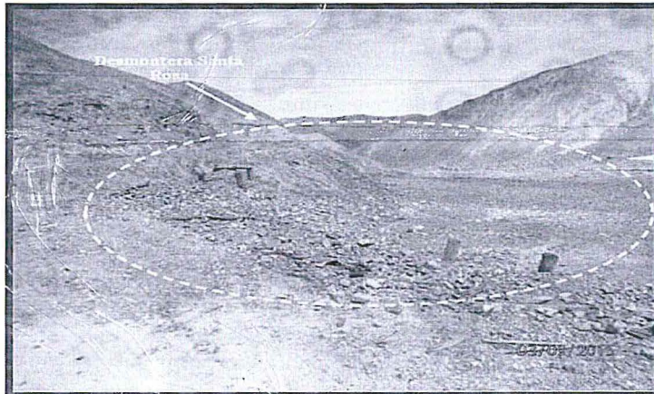
Fotografía N° 28: Vista fotográfica donde se observa la Desmontera Santa Rosa se encuentra sin actividad.
