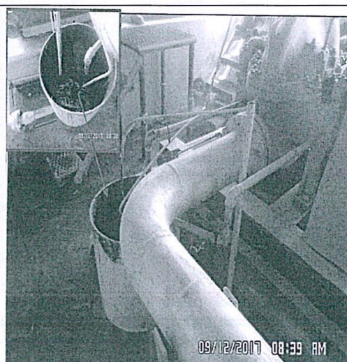
Fotografía 3-C: Electro bomba N° EB-05, en la que se puede observar el sistema de purga donde se originó la fuga de petróleo
