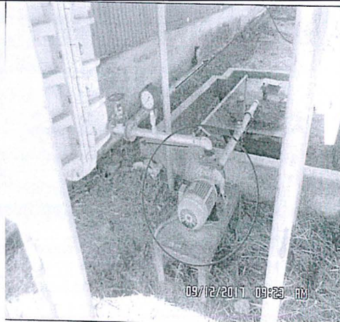
Fotografía 3-C: Electro bomba N° EB-05, en la que se puede observar el sistema de purga donde se originó la fuga de petróleo
