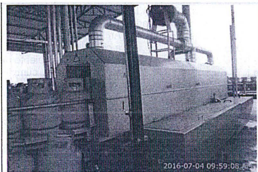
Fotografía N°03 Se observa sistema automático de lavado de balones en etapa de instalación e implementación. A donde llegan los balones por un sistema de carusel. Coordenadas 19 L 8281518 N 0380873 E
