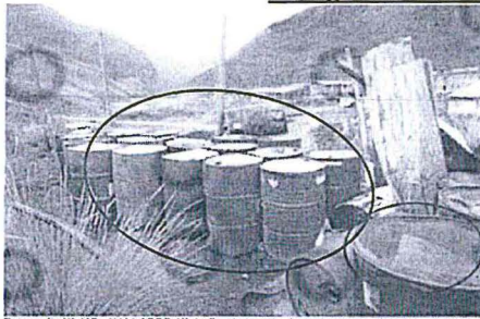
Fotografía N° 107: HALLAZGO N° 1: En el almacén denominada por el titular minero como patio de aceites residuales se observó 03 cilindros conteniendo aceites lubricantes usados, dispuestos sobre el suelo y expuestos al ambiente. Coordenadas UTM Datum WGS84: 8896468 N y 270375 E.
