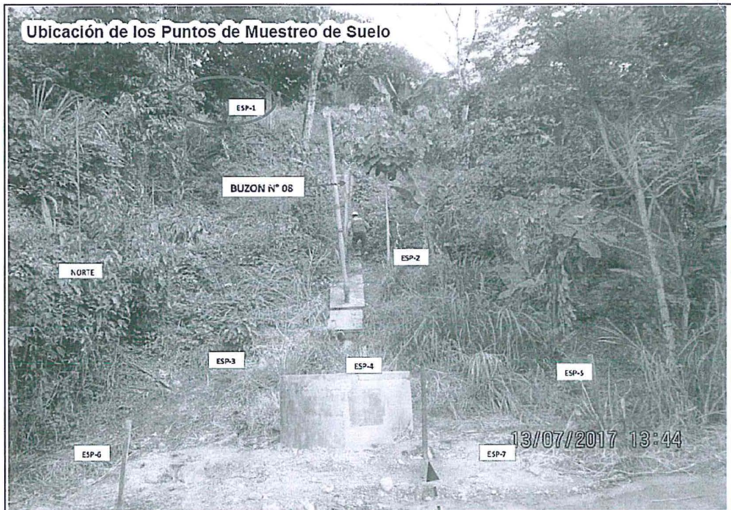
Fuente: Informe de Supervisión
