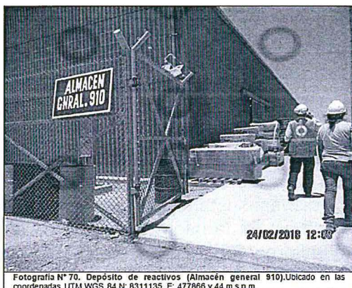
Fotografía N° 70. Depósito de reactivos (Almacén general 910). Ubicado en las coordenadas UTM WGS 84 N: 8311135. E: 477866 y 44 m.s.n.m.
