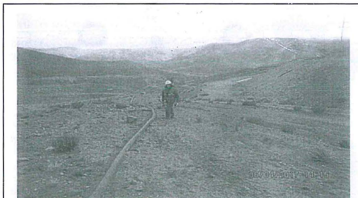
Fotografía N°6. Se observa al personal de OEFA, realizando la revisión de la continuidad de la tubería de conducción implementada, entre la zona del Tajo Valle y Botadero 3, con el fin de evitar la acumulación de agua.
