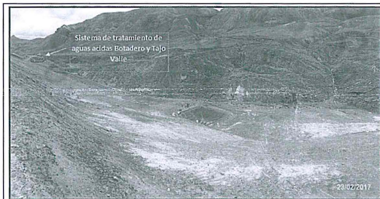
Fotografía N° 6.- Se observa poza de captación revestida con geomembrana HDPE 1.5 mm, asimismo el sistema de tratamiento de aguas acidas, donde se derivarán las aguas del afloramiento natural para su tratamiento respectivo.
