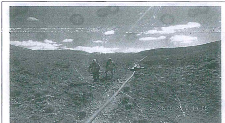
Fotografía N°21. Se observa al personal de OEFA, en la parte final del canal en geomembrana, el cual tiene por fin conducir las aguas de la plataforma observada si es que se generara la misma, asimismo al final del canal se tiene empalmada una tubería de HDPE de 4" con el fin de conducir el flujo de agua hacia el sistema de tratamiento del Botadero N° 3.
