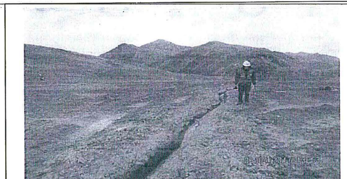
Fotografía N°3. Se observa al personal de OEFA, en la zona denominada entre el Tajo Valle y Botadero N° 3, realizando la constatación de las actividades de control efectuadas por ARUNTANI, ello en razón a la construcción de un canal con el fin de evitar la acumulación de aguas de lluvia.
