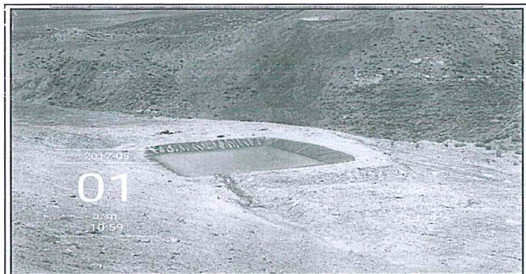
Fotografía N° 7.- Se observa la poza de captación revestida con geomembrana HDPE 1.5 mm; la misma que está conteniendo las aguas de la filtración natural observada.
