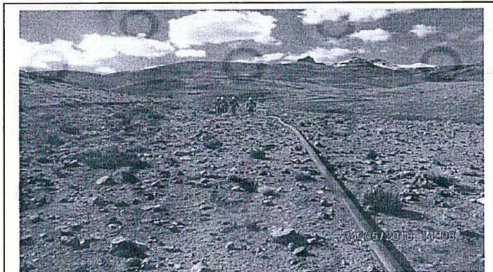
Fotografía N°23. Se observa al personal de OEFA, realizando la revisión de la continuidad de la tubería de conducción implementada, entre la zona del Tajo Valle y Botadero 3, con el fin de evitar la acumulación de agua.
