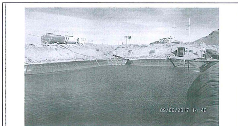
Fotografía N° 17. Se observa la cisterna de agua evacuando el agua succionada la misma que desfoga hacia la poza de almacenamiento de la planta de tratamiento del botadero 1 – Zona Andrés
