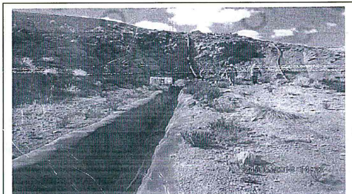
Fotografía N°24. Se observa al personal de OEFA, realizando la revisión de la continuidad de la tubería de conducción implementada y el fin de la misma, la cual se encuentra en el sistema de tratamiento Wetland del botadero N° 3.
