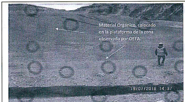
Fotografía N°27. Se observa al personal de OEFA, desde la parte superior constatando la plataforma y la zona por donde discurrió el agua ácida empozada, de entre el Tajo Valle y el Botadero 3, la misma que se encuentra cubierta con material orgánico.
