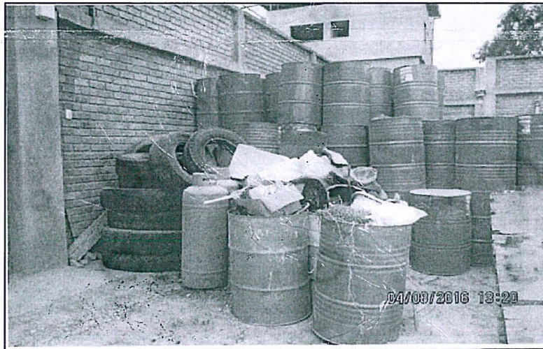
Fotografía N°22 Vista fotográfica se verificó que a un lado del portón metálico de la puerta posterior se viene disponiendo sobre suelo natural 120 cilindros de pintura vacíos de capacidad de 55 gls. Coordenadas UTM WGS 84, zona 17M, 9205459 N, 0777072 E.
