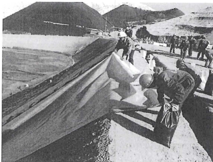
Poza de ferritas impermeabilizada en su totalidad y recibiendo ferritas de zinc
