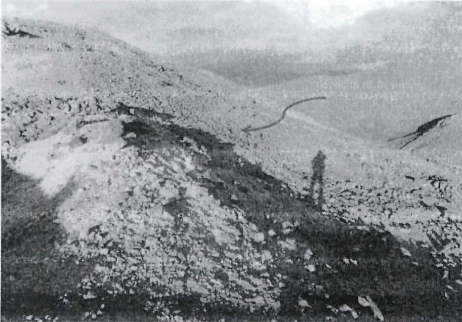
**Fotografía N° 56:** Vista del talud del depósito de desmonte L2-D21-CL, ubicado en las coordenadas UTM (WGS 84), E: 226497 N: 8918759, se observa el material de desmonte expuesto al ambiente, no se ha realizado la remoción y traslado del material.
