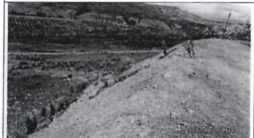
Fotografía N° INC-06. Vista del talud, área N° 3 de 100 m 2 aprox., cubierta con material préstamo y de construcción (piedra chancada y arena), colindante a la cámara de carga.
