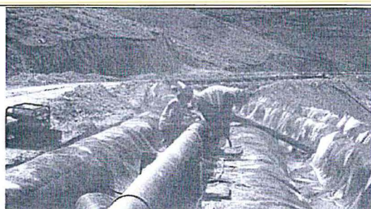
Fotografía N° 20, Vista del personal de la empresa ECOSEM Huaraucaca trabajando en la impermeabilización del canal de contingencia.
