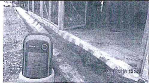
Fotografía N° 13: Vista del canal de coronación en la parte frontal de la cancha de volatilización, ubicado en las coordenadas UTM WGS84: 8 808 301N y 362 242E.
