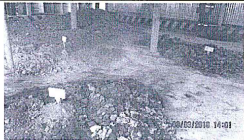
Fotografía N° 15: Vista del manejo suelos empregnados al interior de la cancha de volatilización. Coordenadas UTM WGS84: 8 809 301N y 362 242E.
