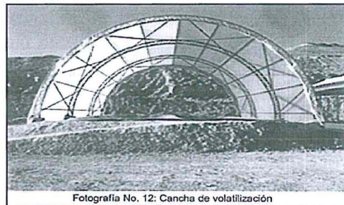
Fotografía No. 12: Cancha de volatilización
