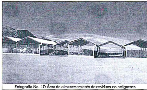
Fotografía No. 17: Área de almacenamiento de residuos no peligrosos
