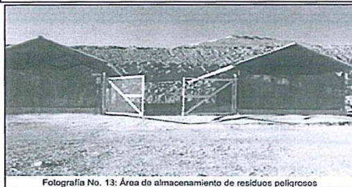
Fotografía No. 13: Área de almacenamiento de residuos peligrosos
