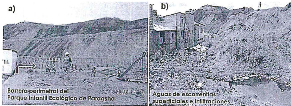
Figura 10-10. Observaciones identificadas en la visita al área de potencial interés ubicado en la localidad de Champamarca, colindante a los Stock Piles: a) Barrera perimetral del parque infantil ecológico de Paragsha, colindante a los Stock Piles de Óxidos de Pasco y b) Acumulación de aguas de escorrentías superficiales e infiltraciones.
