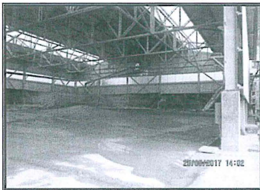
FOTOGRAFÍA N° 69. Patio de Relaves. Construido con estructuras metálicas, muro y piso de concreto. En dicha área se almacenaba el relave grueso para luego ser transportado mediante camiones a mina subterránea y ser utilizados como relleno en interior mina. El relave fino era llevado a la estación de bombeo 2 para ser luego ser conducidos al depósito de relaves C.
