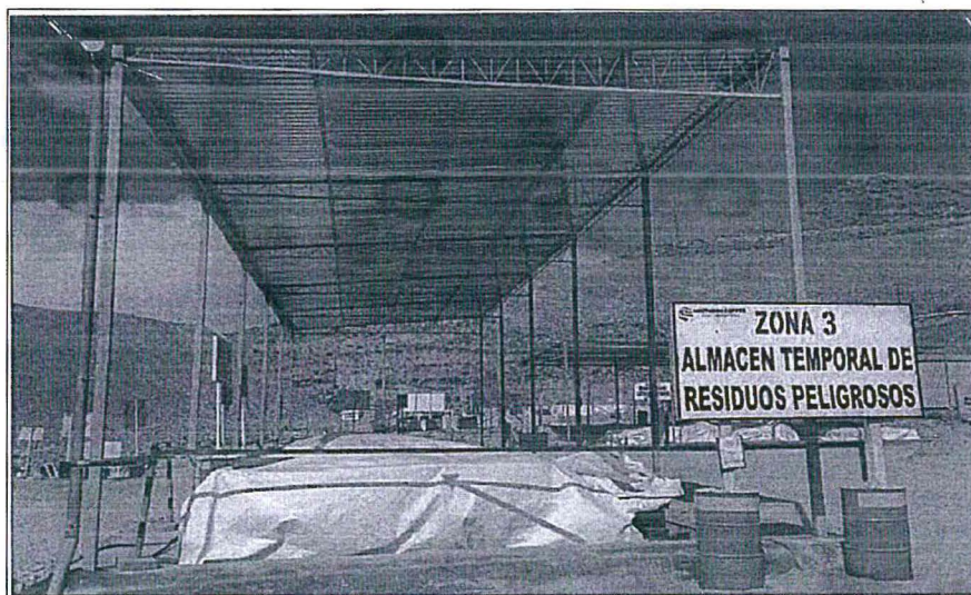
Vista del almacén de residuos peligrosos con techo metálico.
