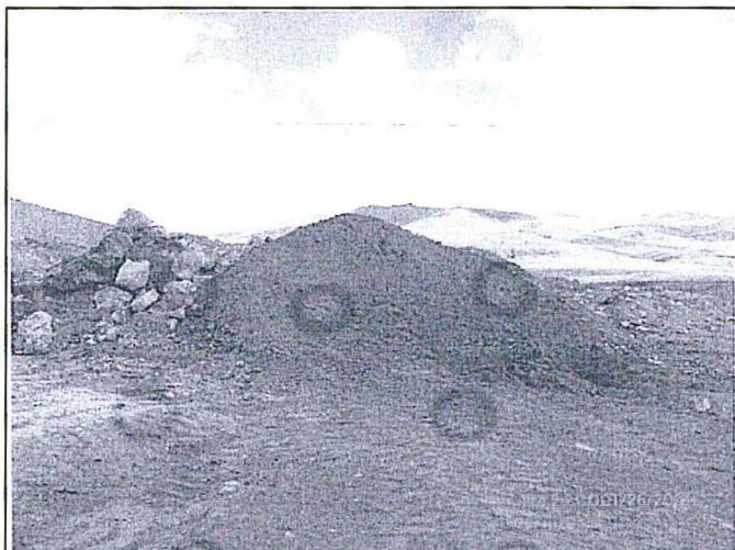
Fotografía N° 141: Hallazgo N° 01, Top soil depositado en la zona del boladero de material excedente de la curva Cumani, nótese que aparentemente el desbroce se ha realizado correctamente.
