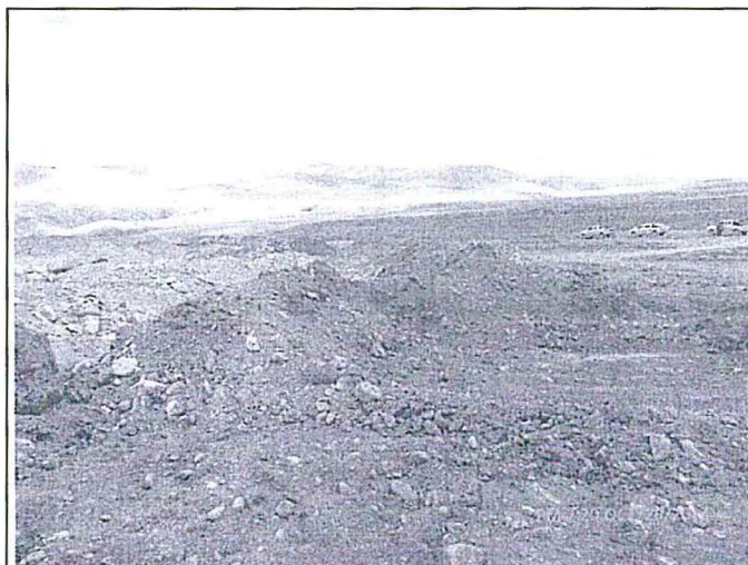
Fotografía N° 143: Hallazgo N°01, Top soil depositado en el depósito de material excedente de la curva Cumani.
