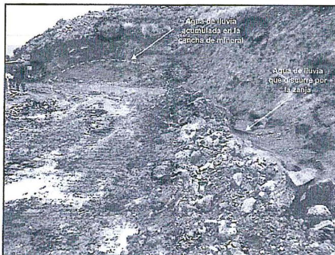
Fotografía N°09: Vista fotográfica donde se aprecia la cancha de mineral de baja ley, aquí se observa una zanja al lado de la cancha por donde discurre el agua de escorrentía.
