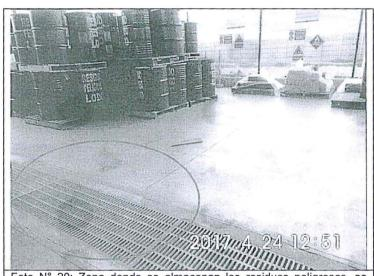
Foto N° 20: Zona donde se almacenan los residuos peligrosos, se observa cilindros metálicos conteniendo lodo residual de la PTAR, asimismo se observa canaleta que actúa como sistema de contención.
