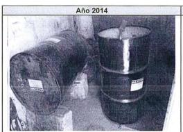
Fotografía N° 13-B: Se observan que el área de almacenamiento de productos químicos no cuenta con sistema de contención ni señalización que identifique dicha instalación como tal.
