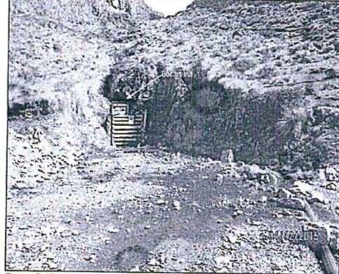
Fotografía N° 18: Bocamina Bedoya; se observa la presencia de filtración de agua por el piso de la bocamina hacia el suelo natural. COORDENADAS UTM WGS84 8698793N, 502719E.
