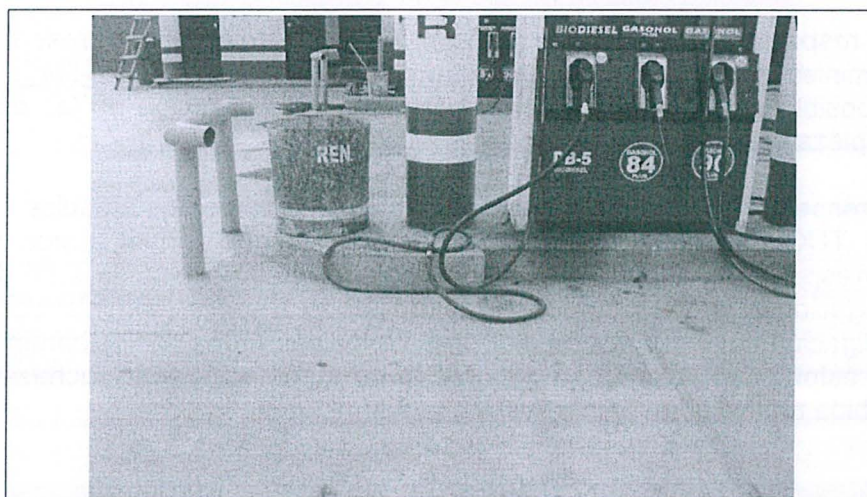
Fotografía N° 05. Vista del contenedor de arena, cuya ubicación es cercana al derrame de combustible (Diésel B5), personal operario no recibe capacitación ante contingencias como ésta.
